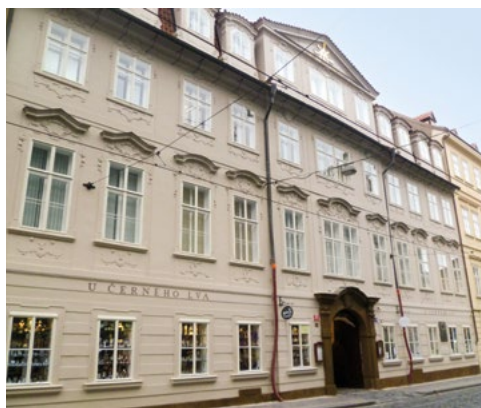
Karmelitská 379/18, Praha 1, k. ú. Malá Strana – oprava fasády
