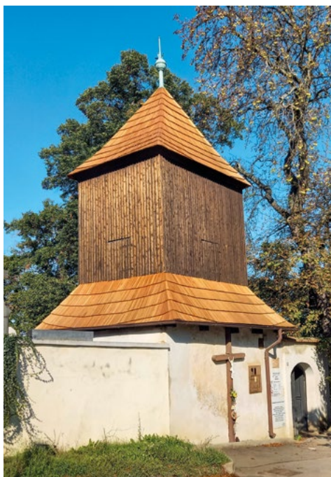
Kostel sv. Vavřince Praha-Jinonice, Vavřínecká, Praha 5, k. ú. Jinonice – havarijní oprava šindelové krytiny zvonice u kostela sv. Vavřince
